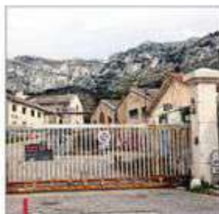
Face à la mer, le long de l'avenue de la Madrague-de-Montredon, le site de Legré-Mante annonce sa métamorphose. 85 % des bâtiments, parmi lesquels le plus ancien qui date de 1850, seront conservés tout comme l'emblème du site, la cheminée ou briquet de 32 mètres de hauteur.
