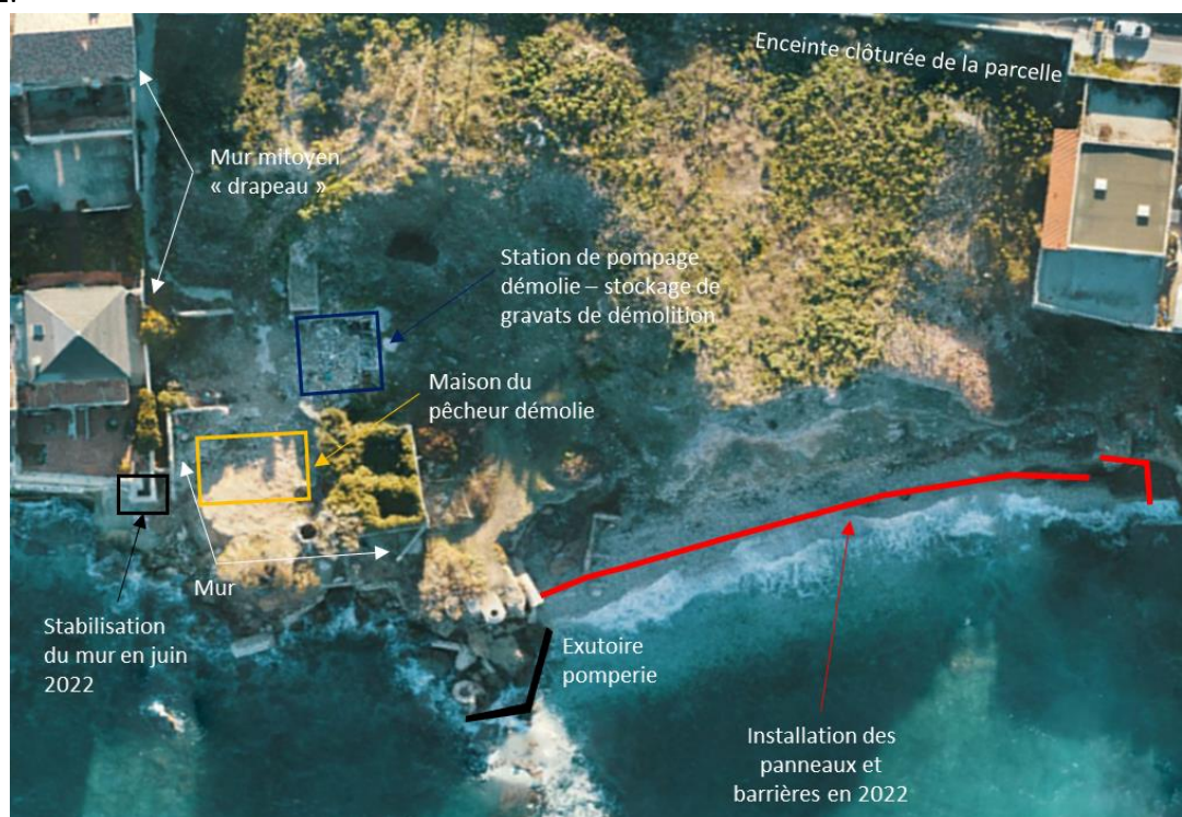
Figure 2 : Situation de la parcelle après travaux de sécurisation en pied de talus (juin 2022)
