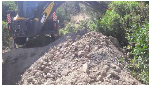
Fouilles à la PM pour prélèvements de matériaux en vue de tests laboratoire
