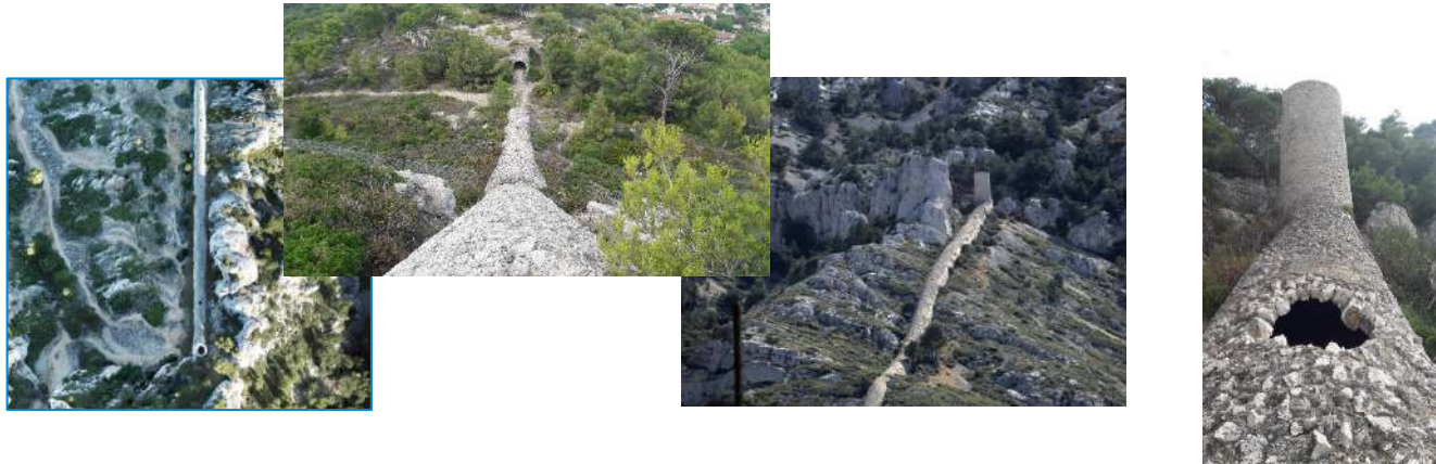
Vue de la cheminée rampante et de son exutoire
